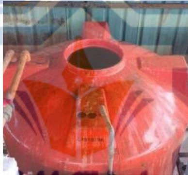
Gambar 3.14 Tangki Reduksi (Bak Limbah Asam) PT X
