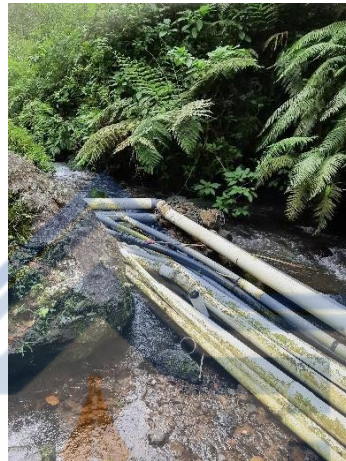
Gambar 3.3 Kondisi Eksisting Intake
