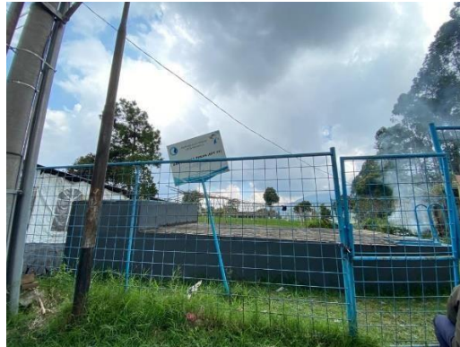
Gambar 3.4 Kondisi Eksisting Intake
