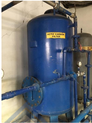
Gambar 4. 3 Actif Carbon Filter
