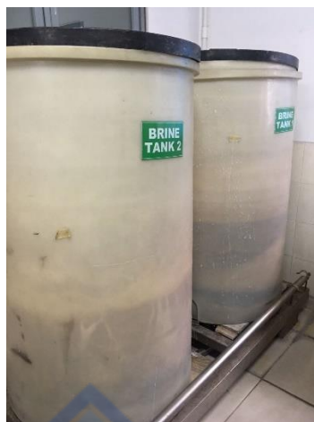
Gambar 4. 12 Tangki NaCl
